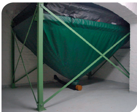
[Fig. 5] Silo à levage
